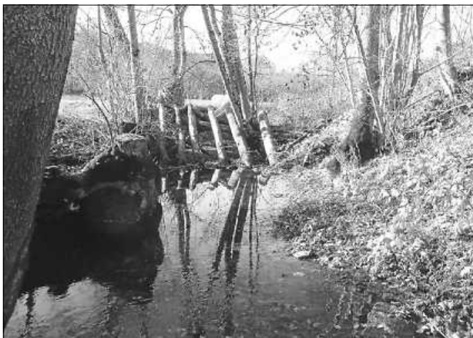
Hochwasserschutzrechen vor Jungingen
