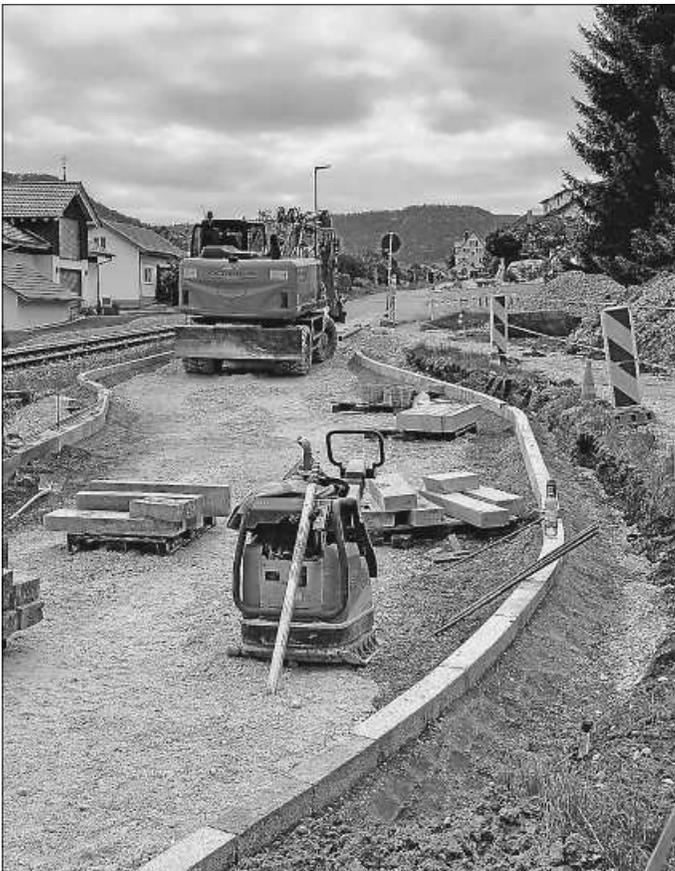
Die Arbeiten an der Verschwenkung Hochmeisterstraße laufen trotz des anhaltenden, schlechten Wetters gut. Die Bordsteinkanten auf beiden Seiten konnten bereits inklusive neuer bzw. geänderter Kabeltrasse fertiggestellt werden. Je nach Wetterlage soll der „Fertiger“ – die Maschine zum Einbringen des Stra-
