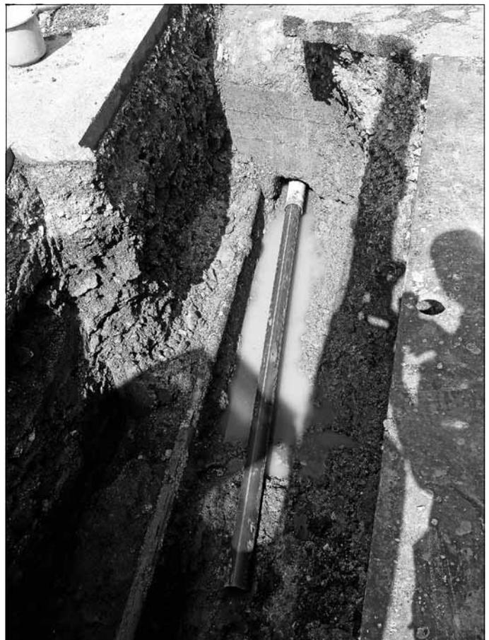
Nachdem die Spülbohrarbeiten fertiggestellt waren, stellte die Gemeinde starke Wasserverluste im Bereich Frischwasserversorgung fest. Wie erwartet hatte die etwa 45 Jahre alte Leitung vermutlich aufgrund der Vibrationen oder des Drucks Schaden genommen – obwohl die Bohrungen mehr als vier Meter davon entfernt stattfanden. Nun musste auch noch diese Leitung der Gemeinde erneuert werden. Diese machte es den Bauhofmitarbeitern und den hinzugezoge-
