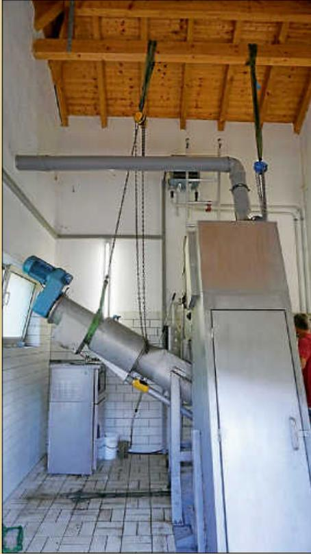
Früher: Diagonal angeordnete Waschpresse mit integrierter Schnecke
